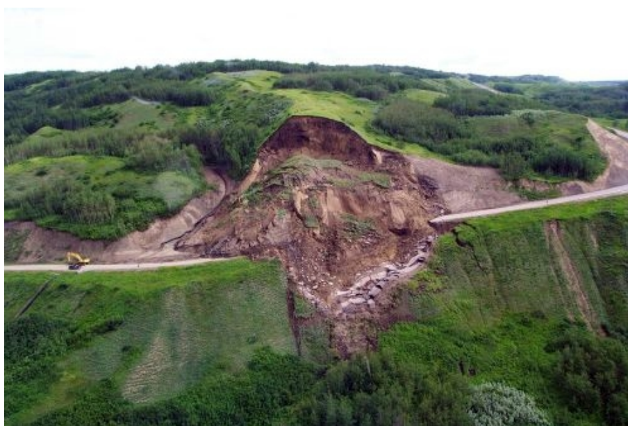
Slika 2-Prekid saobraćajnice usled klizišta
