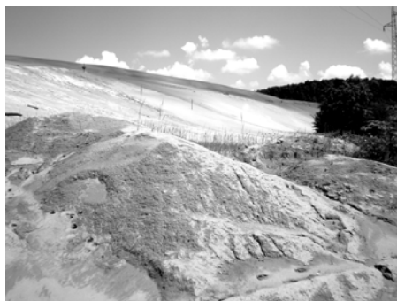
Slika 2. Izgled dela brane flotacijskog jalovišta Valja Fundata u Majdanpeku
