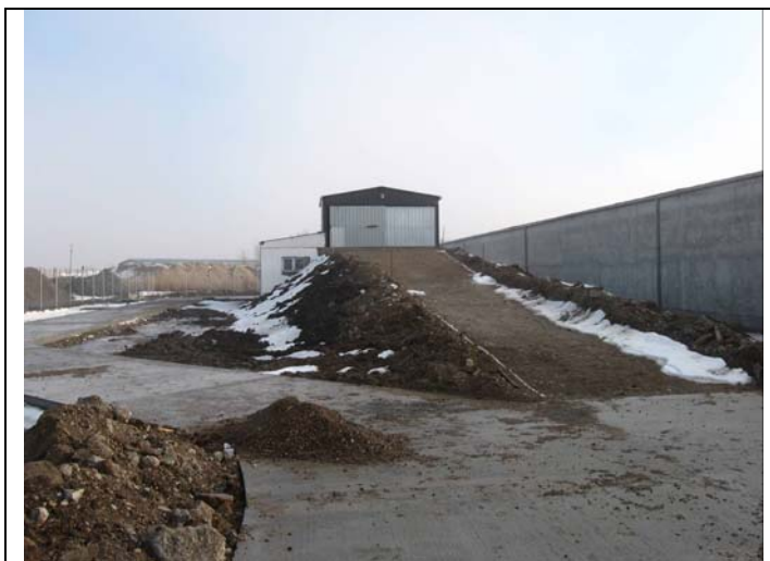
Slika 2. Prilazni put, prilazna rampa za istovar otpada u objekat
