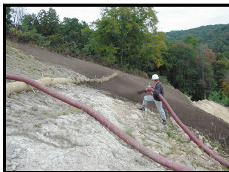
Slika 2. Izvođenje hidrosetve
